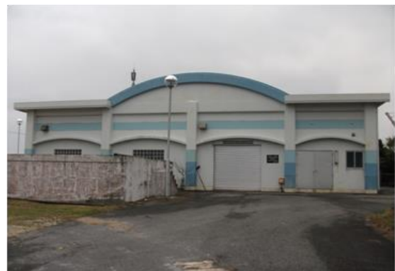
■多良間村浄水処理施設
