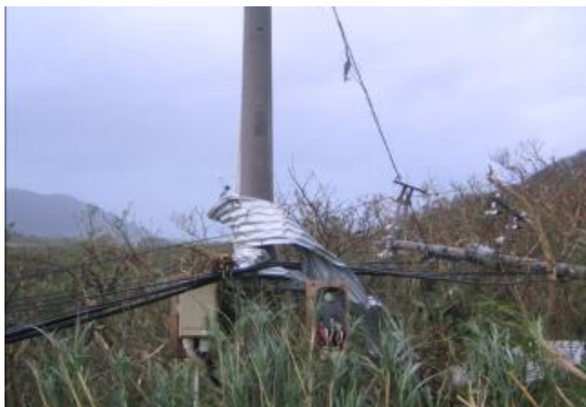
電柱に巻き付いたトタン屋根と破壊されたプレハブと屋根から落下した貯水タンク(沖縄気象台提供)
