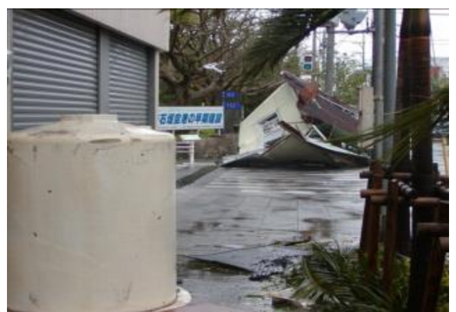
電柱に巻き付いたトタン屋根と破壊されたプレハブと屋根から落下した貯水タンク(沖縄気象台提供)
