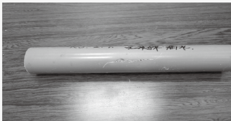
傷ついて漏水を起こした水道管
