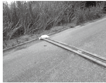
かん水資材設置状況
