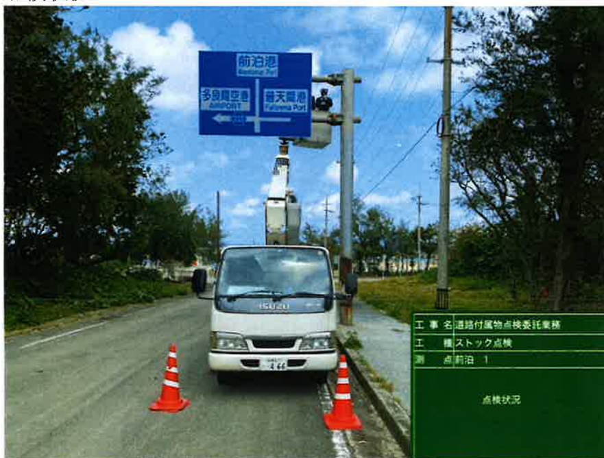
多良間港線 点検状況
