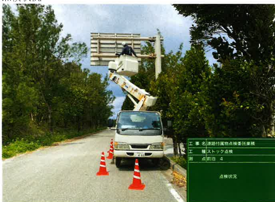
塩川仲筋線 点検状況
