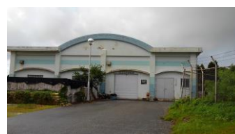
多良間村簡易水道浄水処理施設
