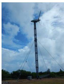
可倒式風力発電
