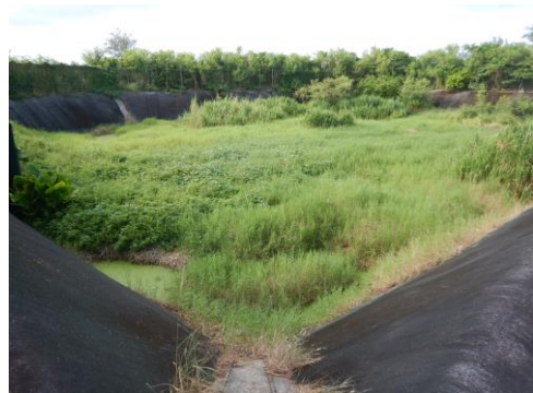
クリーンセンター：最終処分場
