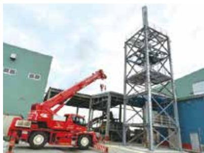
急ピッチで進む施工状況(11月26日)
