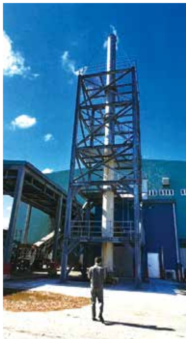
完成した煙突の外観(11月30日)
