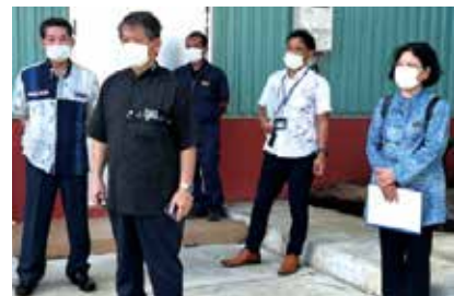
照屋義実沖縄県副知事 煙突被災状況視察。亀浜玲子政策参与(右)、伊良皆村長(左)(9月28日)
