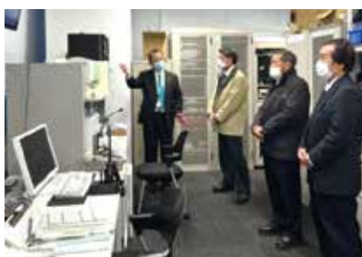
各地に設置した監視カメラやスクリーン、モニターなどを備えた防災システムの説明を受ける
