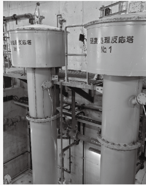
硬度処理反応塔 (硬度低減が図られている)
