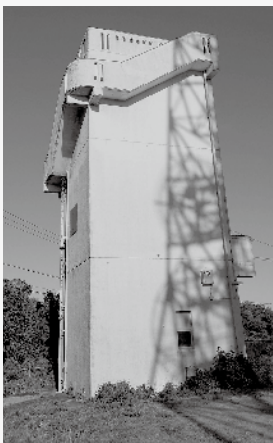
村浄水処理施設高架タンク (昭和60年建設)
