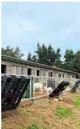
多良間村山羊舎施設
