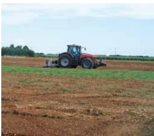
種子川地区のストーンクラッシャー
